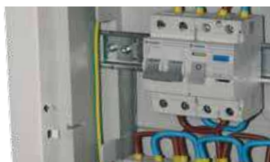
135 mm between DIN rails 135 mm entre rail DIN
